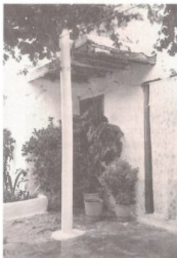
(Φωτ. 54) Κεφαλόσκαλο κατοικίας της β' φάσεως. Στις δύο ανοικτές πλευρές του έφερε ξύλινο προστατευτικό κιγκλίδωμα
