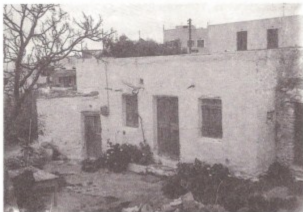
(Φωτ. 7) «Κουζινάκι», κυρίως δωμάτιο και βοηθητικός χώρος
